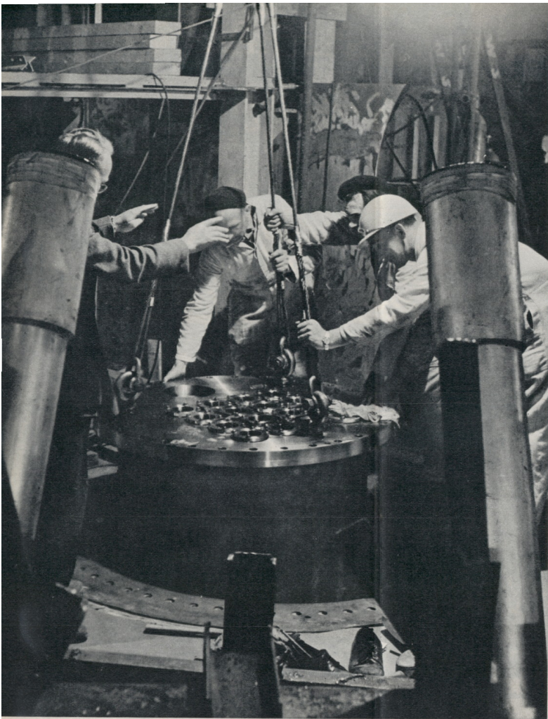
Heel gewone mannen in witte overallis verrichten hier belangrijk werk. Zij bouwen het stalen pantserhuis van de reactor.
