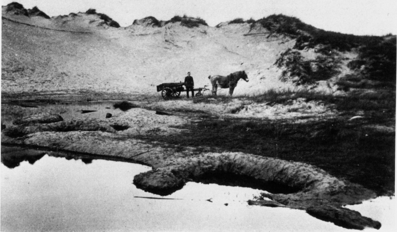
De Zandkuil in Petten in 1936, Arie Eriks Hzn. haalt een wagen zand uit het braakliggende terrein. Tijdens WO II zouden op deze plek bunkers worden gebouwd. Op dit moment is hier Camping 'Het Korfwater' gevestigd.
