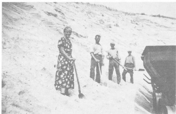
Zandscheppen in de zandmennenrij
