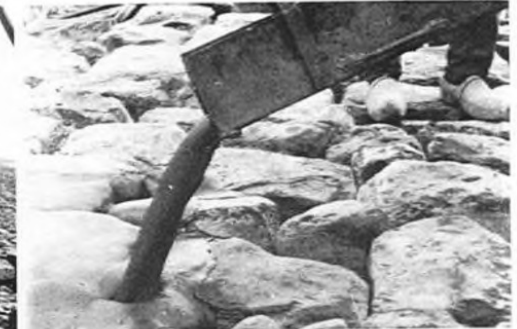
Het ingieten van de bestorting voor de hoofden met gietasfalt
