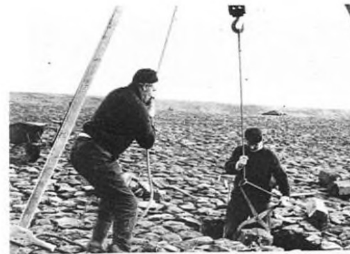
Herzetten van basaltzuilen 40/50 in de glooiing
